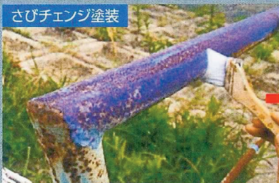
下地処理(3種ケレン)後にさびチェンジ塗装。
