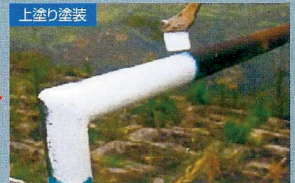
乾燥後、一般塗料で上塗り塗装。
